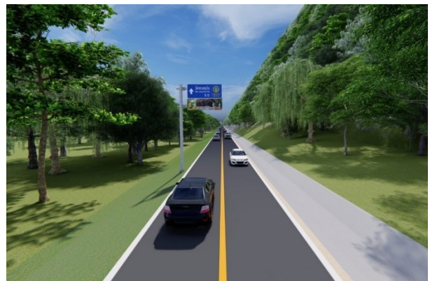
รูปที่ 13 ภาพ 3 มิติ ถนนขนาด 2 ช่องจราจร กว้าง 3.50 เมตร
