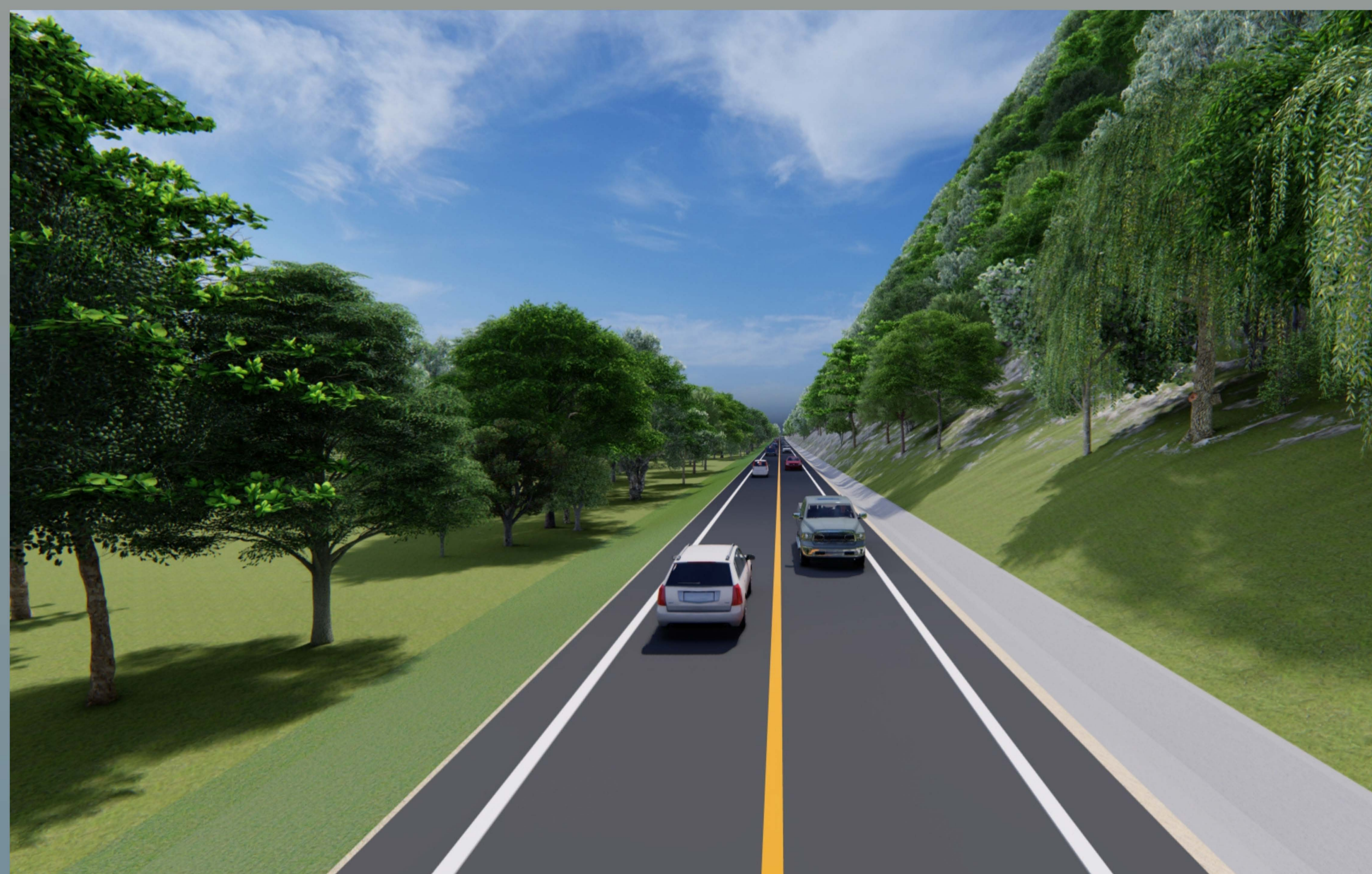
ภาพ 3 มิติ ถนนขนาด 2 ช่องจราจร กว้าง 3.00 เมตร ไหล่ทาง 1 เมตร
