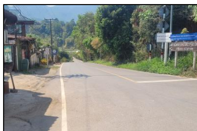
ทางหลวงชนบทสาย ชม.4053
