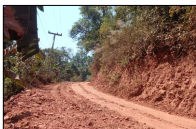
ทางหลวงชนบทสาย ชม.6050
