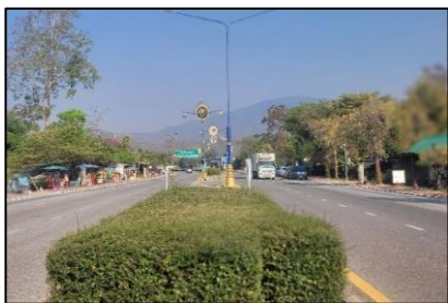
ทางหลวงชนบทสาย ชม.3028
