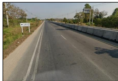
ทางหลวงชนบทสาย ชม.3035
